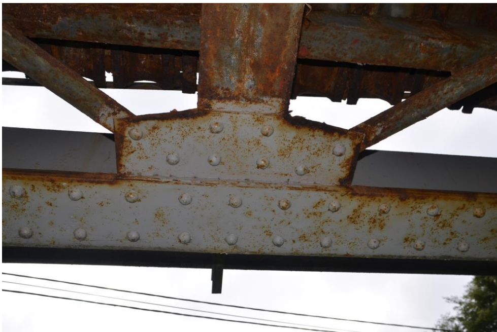
Obr.G47-39 Detail připojení (styčníku) vodorovného zavětrování příčnickového pole č.5 a č.6 a příčník č.6 na dolní pás pravého příhradového nosníku. Pohled zleva doprava, po vodě a vzhůru,
