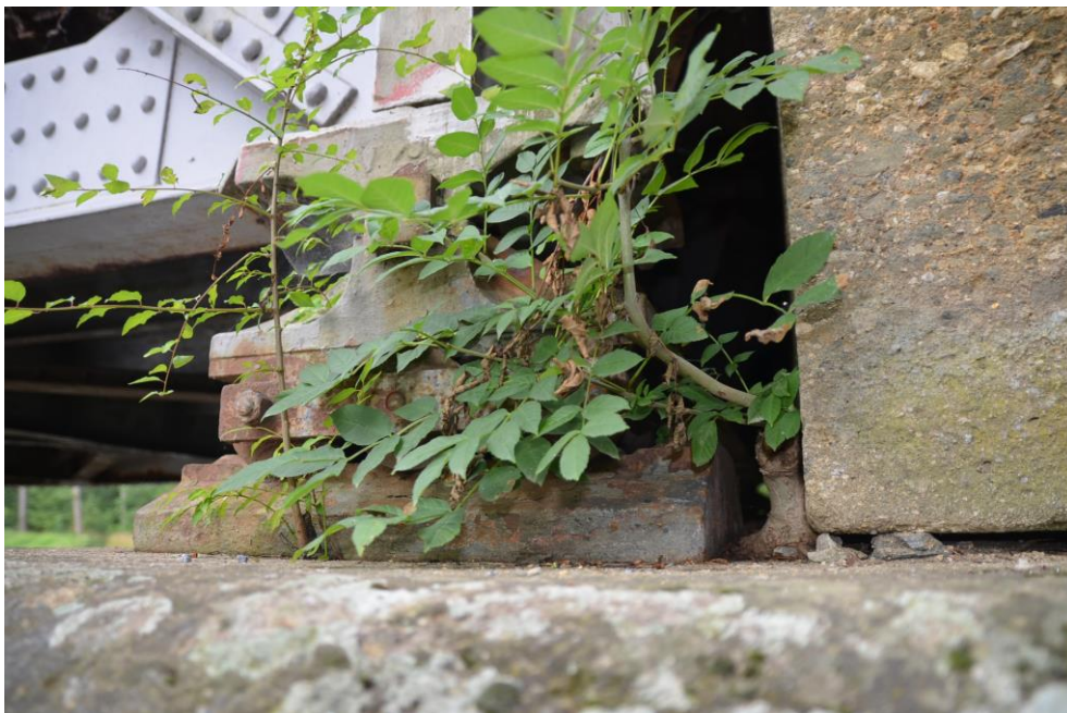
Obr.G47-50 Pohyblivé ložisko č.2 (pravé) na druhé podpěře, tulešické opěře. Pohled proti směru staničení a zprava doleva, proti vodě,
