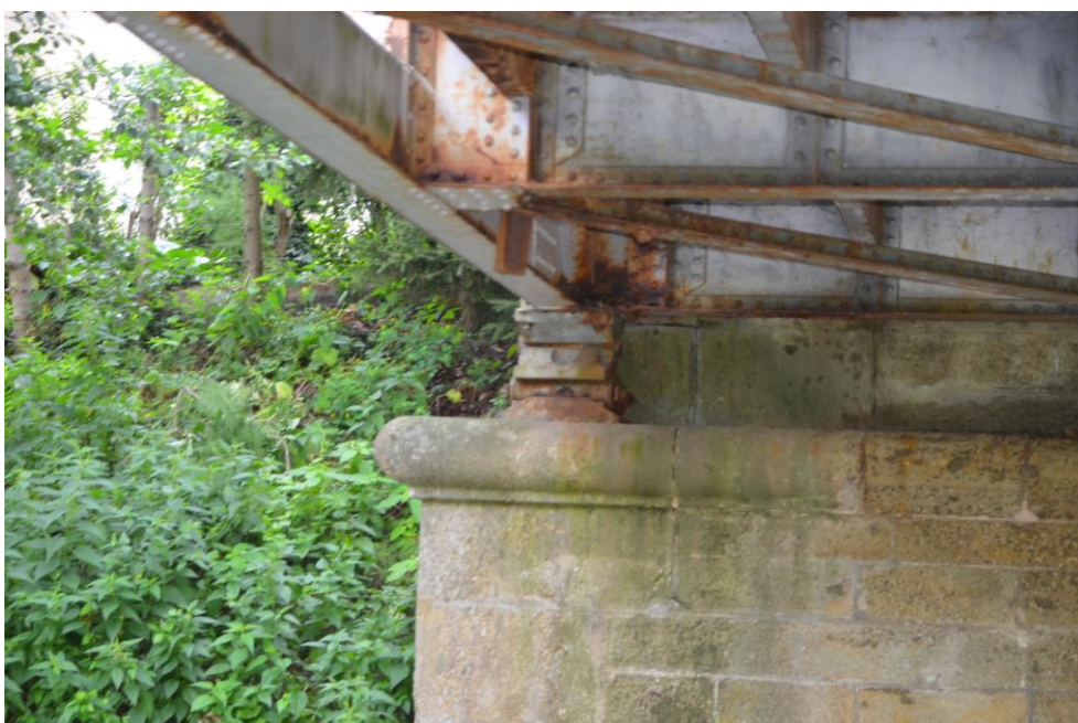
Obr.G47-48 Pohyblivé ložisko č.1 (levé) na druhé podpěře, tulešické opěře. Pohled zprava doleva, proti vodě a ve směru staničení,
