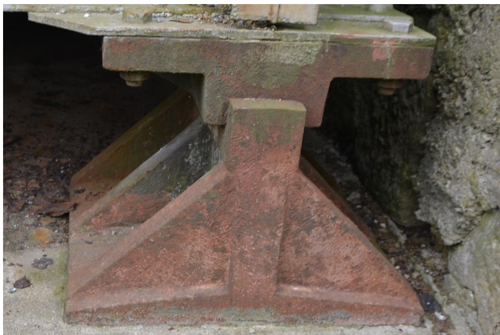
Obr.G47-44 Nepohyblivé ložisko č.1 (levé) na první podpěře, tavíkovické opěře. Pohled zleva doprava, po vodě,
