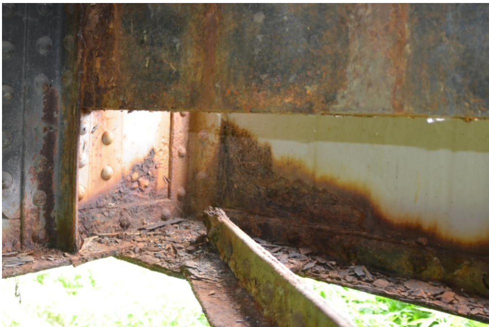
Obr.G47-41 Detail připojení (styčnicku) vodorovného zavětrování příčnickového pole č.1 a příčnick č.2 na dolní pás pravého příhradového nosníku. Pohled ve směru staničení a zleva doprava, po vodě,
