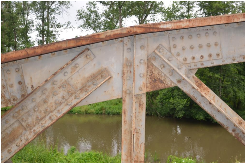
Obr.G47-31 Detail připojení (styčnicku) diagonály č.1 a č.2 a svislice č.2 na horní pás levého příhradového nosníku. Pohled zprava doleva a proti vodě a vzhůru,
