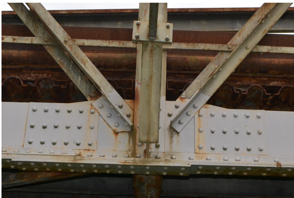
Obr.G47-42 Detail připojení (styčnicku) diagonály č.4 a č.5 a svislice č.5 na dolní pás pravého příhradového nosníku. Pohled zleva doprava, po vodě a vzhůru
