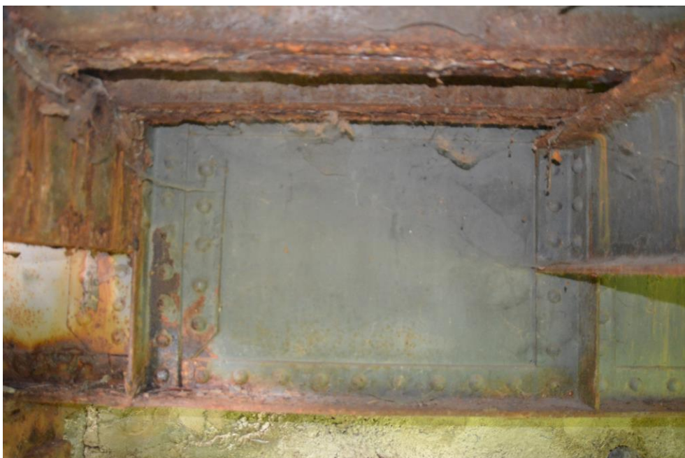
Obr.G47-37 Detail připojení (styčnicku) podélných nosníků mostovky č.4 a č.5 na příčník č.1. Pohled proti směru staničení,
