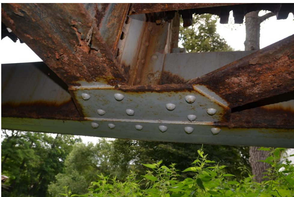
Obr.G47-40 Detail připojení (styčníku) vodorovného zavětrování příčnickového pole č.1 a příčník č.2 na dolní pás pravého příhradového nosníku. Pohled ve směru staničení a zleva doprava, po vodě,
