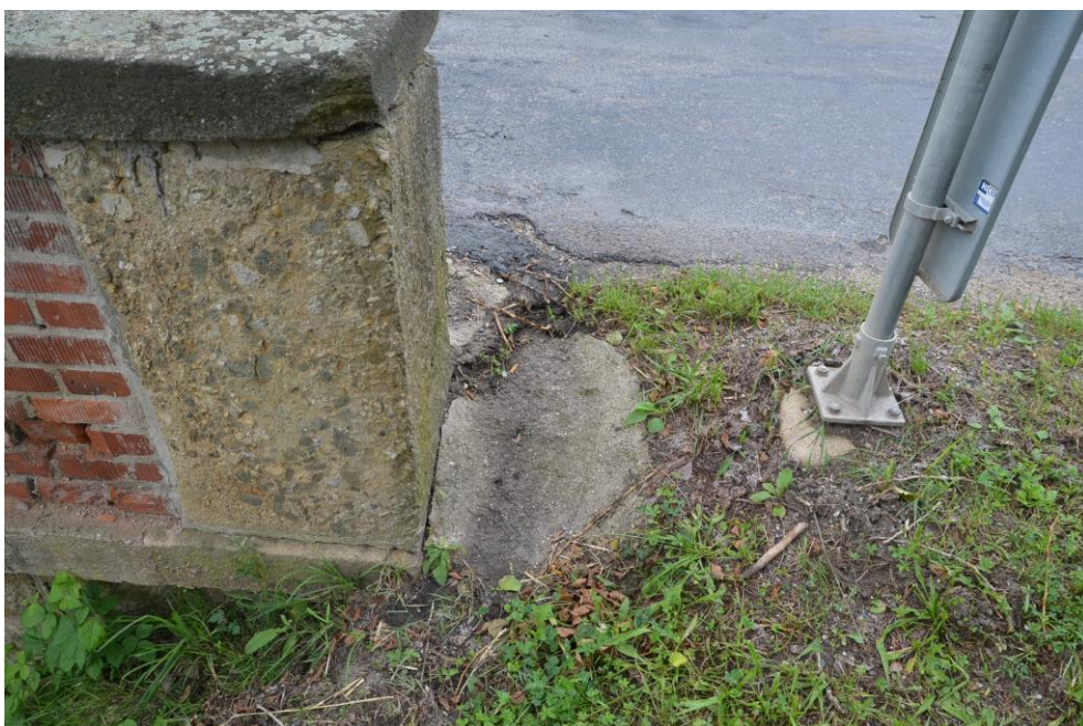
Obr.G47-58 Detail odvodňovacího skluzu za druhou podpěrrou, tulešickou opěrrou na pravé straně mostu. Pohled zprava doleva, proti vodě a dolů
