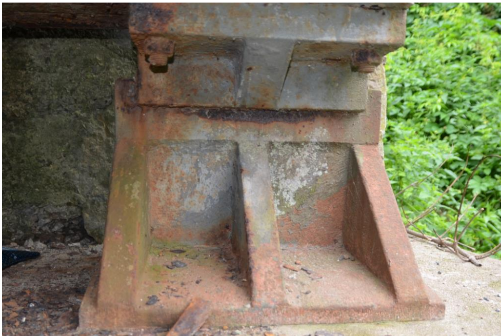
Obr.G47-43 Nepohyblivé ložisko č.1 (levé) na první podpěře, tavíkovické opěře. Pohled proti směru staničení,
