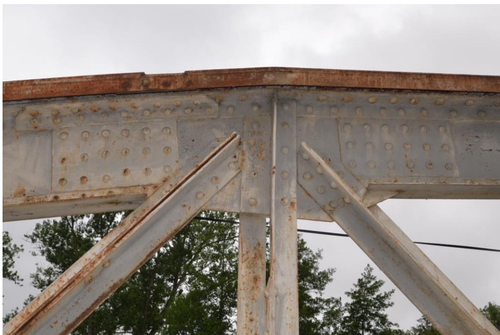
Obr.G47-33 Detail připojení (styčnicku) diagonály č.3 a č.4 a svislice č.4 na horní pás levého příhradového nosníku. Pohled zprava doleva a proti vodě a vzhůru,
