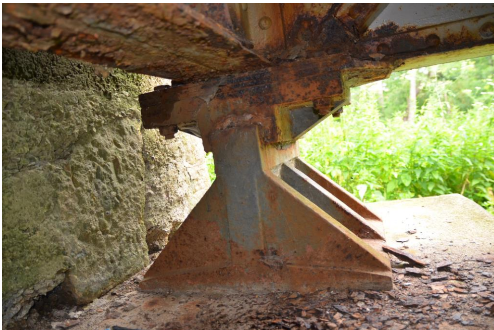
Obr.G47-45 Nepohyblivé ložisko č.1 (levé) na první podpěře, tavíkovické opěře. Pohled zprava doleva, proti vodě,
