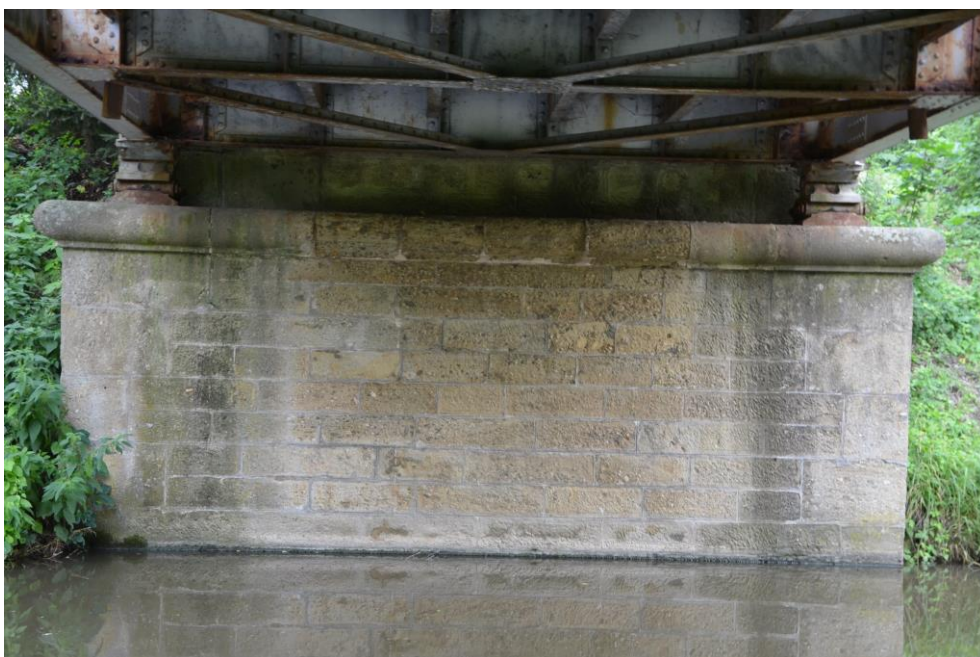
Obr.G47-08 Druhá podpěra, tulešická opěra. Pohled na její líc ve směru staničení, - opěra je z řádkového zdiva z kamene. Kusové stavivo (kámen) je kvalitní. Spáry v minulosti povrchově vyspraveny spárovací maltou, která je místy postižena trhlinami, anebo zcela chybí. Za spárovací maltou se nachází původní malta, která je vlhká a velmi nekvalitní (bez tmele), - na lící opěry stopy po zatékání přes MZ a uchycené mikroorganismy, - úložné prahy opěr jsou zřízeny z opracovaných kvádrů z pískovce, - kusové stavivo (přírodní kámen) vlivem zvýšené vlhkosti povrchově degraduje, - závěrné zídky zřízeny z monolitického betonu.
