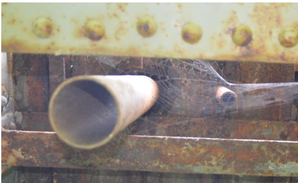
Obr.G47-56 Podhled odpadní trouby odvodnění povrchu vozovky a hydroizolace mostu v příčnickovém poli č. 4. Pohled vzhůru,
