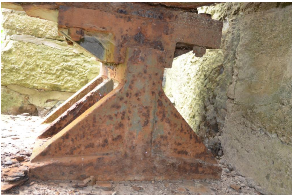
Obr.G47-47 Nepohyblivé ložisko č.2 (pravé) na první podpěře, tavitkovické opěře. Pohled zleva doprava, po vodě,
