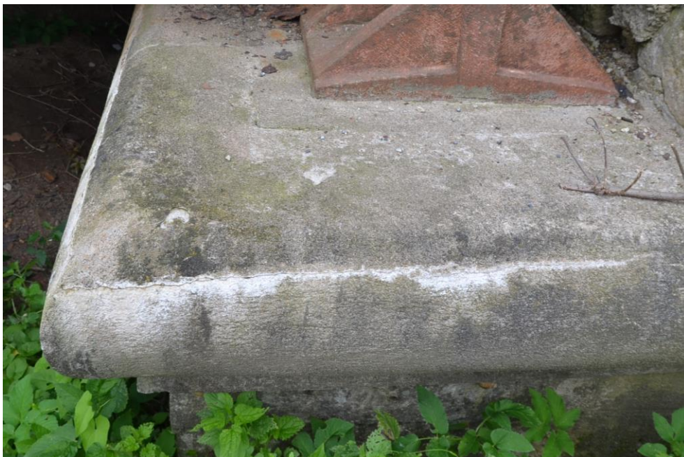
Obr.G47-07 Detail levého čela úložného prahu první podpěry, tavíkovické opěry. Pohled zleva doprava, po vodě a dolů, - na levém čele UP první podpěry, tavíkovické opěry trhliny se stopami po zatékání s vápennými výluhy.
