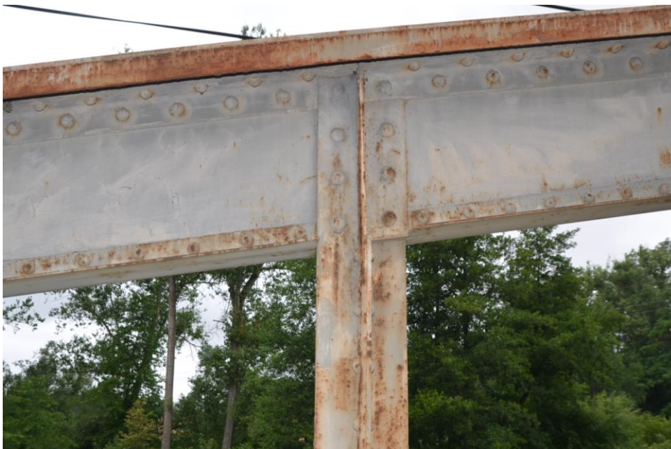
Obr.G47-32 Detail připojení (styčnicku) svislice č.3 na horní pás levého příhradového nosníku. Pohled zprava doleva a proti vodě a vzhůru,
