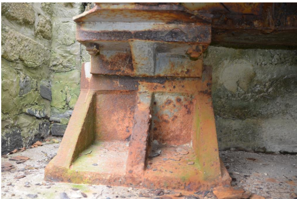
Obr.G47-46 Nepohyblivé ložisko č.2 (pravé) na první podpěře, tavíkovické opěře. Pohled proti směru staničení,
