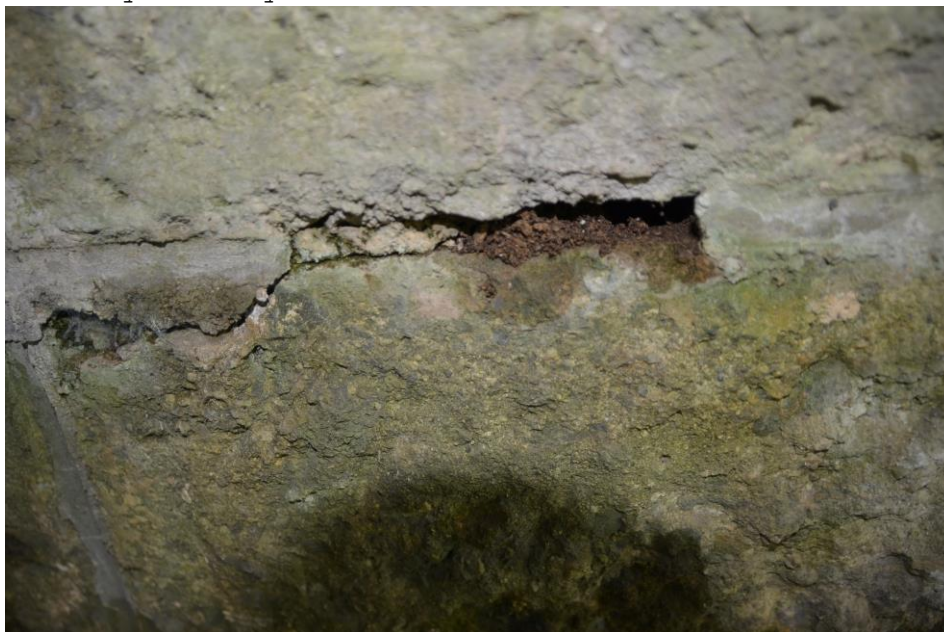
Obr.G47-06 Příklad spáry první podpěry, tavíkovické opěry. Pohled na její líc proti směru staničení,
