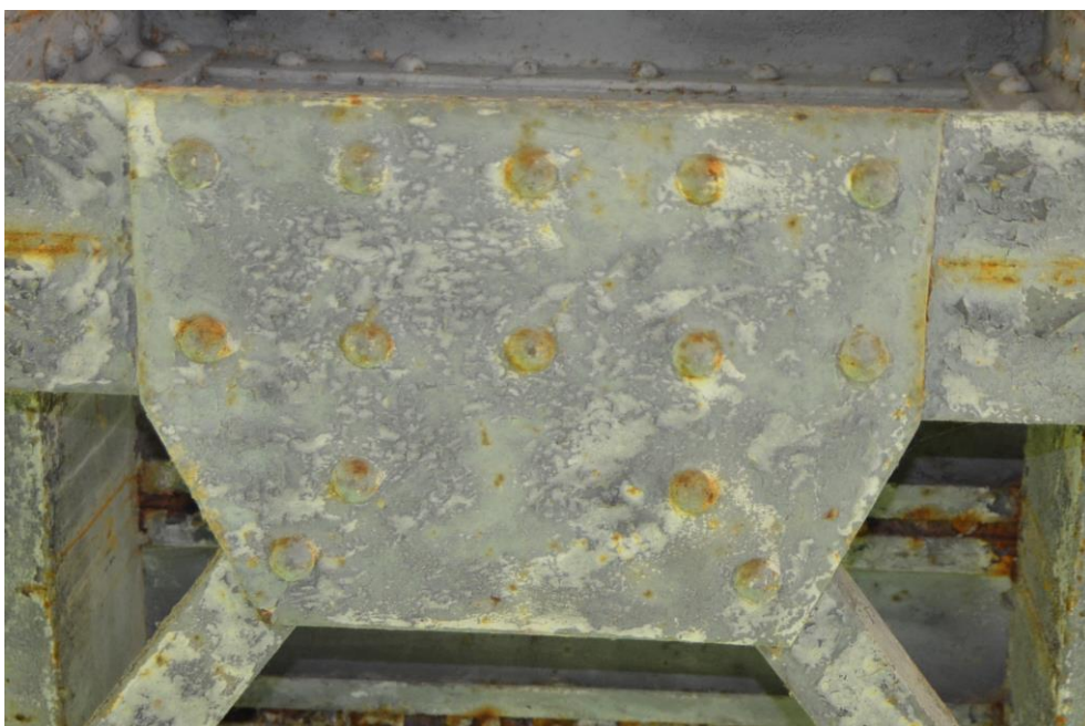
Obr.G47-38 Detail připojení (styčnicku) vodorovného zavětrování na příčník č.7. Pohled proti směru staničení a vzhůru,
