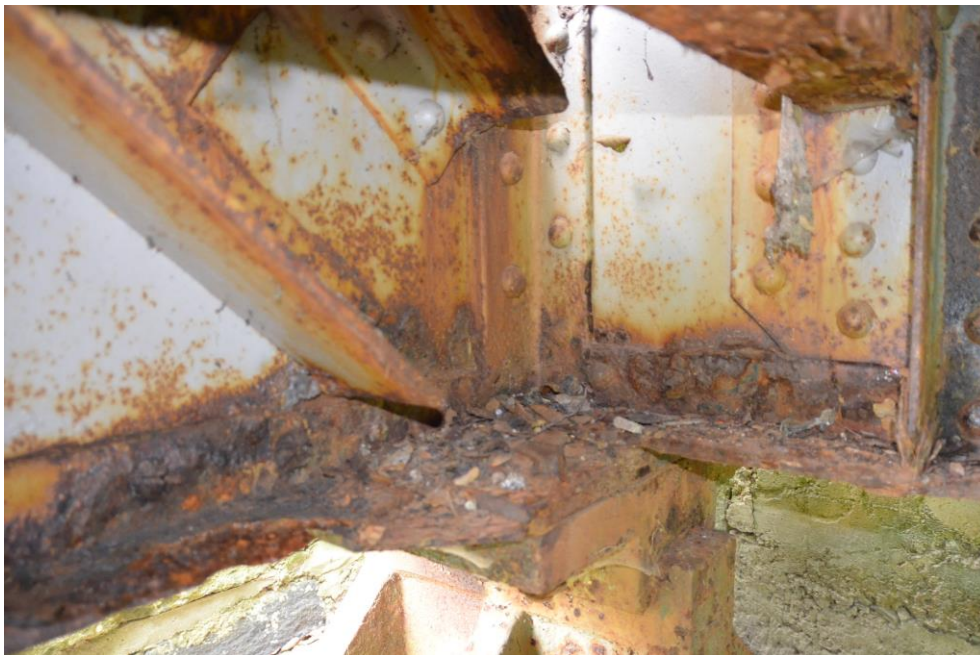
Obr.G47-35 Detail připojení (stýčnicku) diagonály č.1 svislice č.1 na dolní pás pravého příhradového nosníku. Pohled zleva doprava, po vodě a proti směru staničení,
