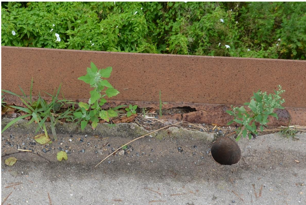
Obr.G47-55 Detail odpadní trouby odvodnění povrchu vozovky v příčnickovém poli č. 5. Pohled zleva doprava, po vodě a dolů,
