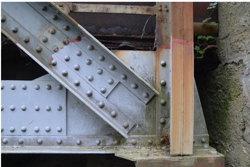
Obr.G47-36 Detail připojení (stýčnicku) diagonály č.1 svislice č.1 na dolní pás levého příhradového nosníku. Pohled zleva doprava a po vodě,
