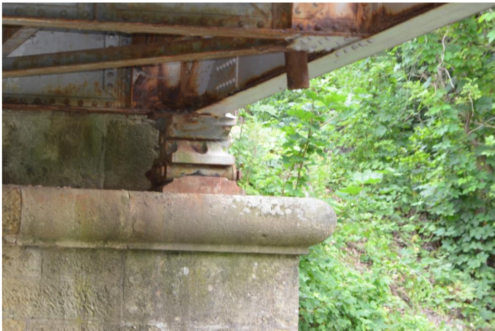
Obr.G47-49 Pohyblivé ložisko č.2 (pravé) na druhé podpěře, tulešické opěře. Pohled ve směru staničení a zleva doprava, po vodě
